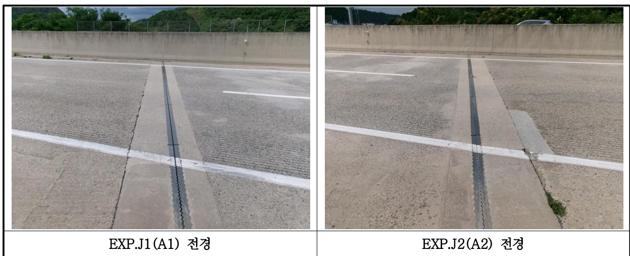
【사진 22.3.39】 신축이음장치 전경
