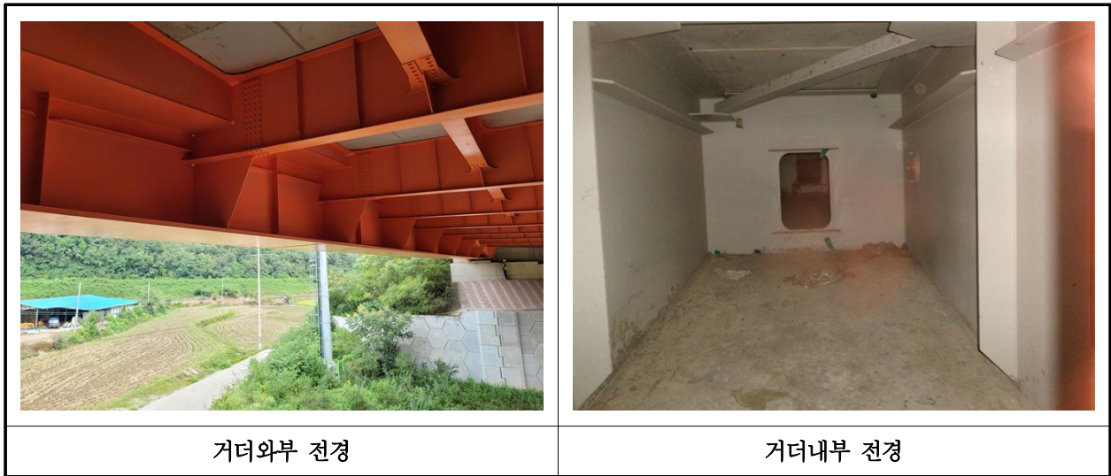
【사진 22.3.4】 거더 전경
