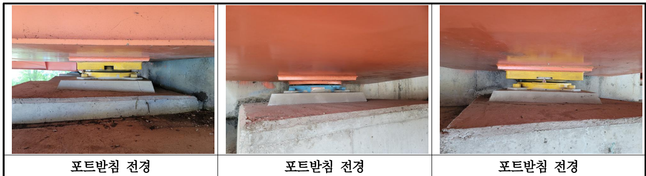
【사진 22.3.35】 교량받침 전경
