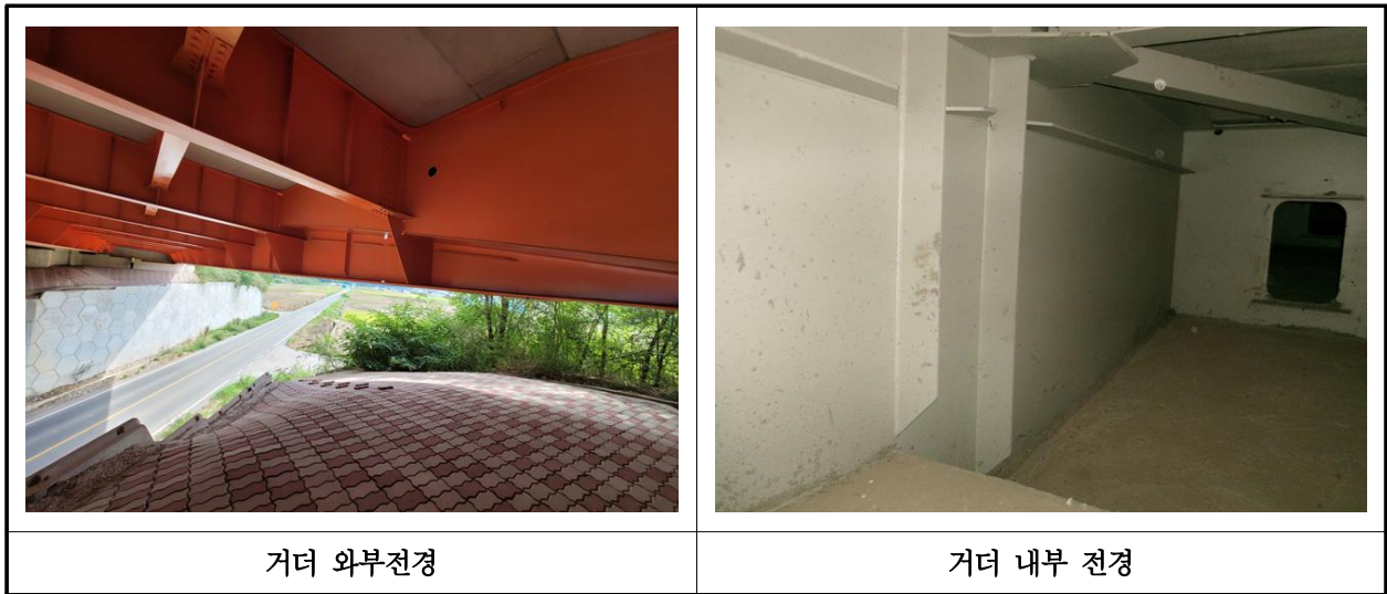
【사진 22.3.28】 거더 전경
