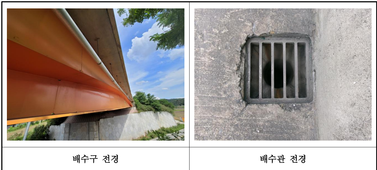
【사진 22.3.44】 배수시설 전경
