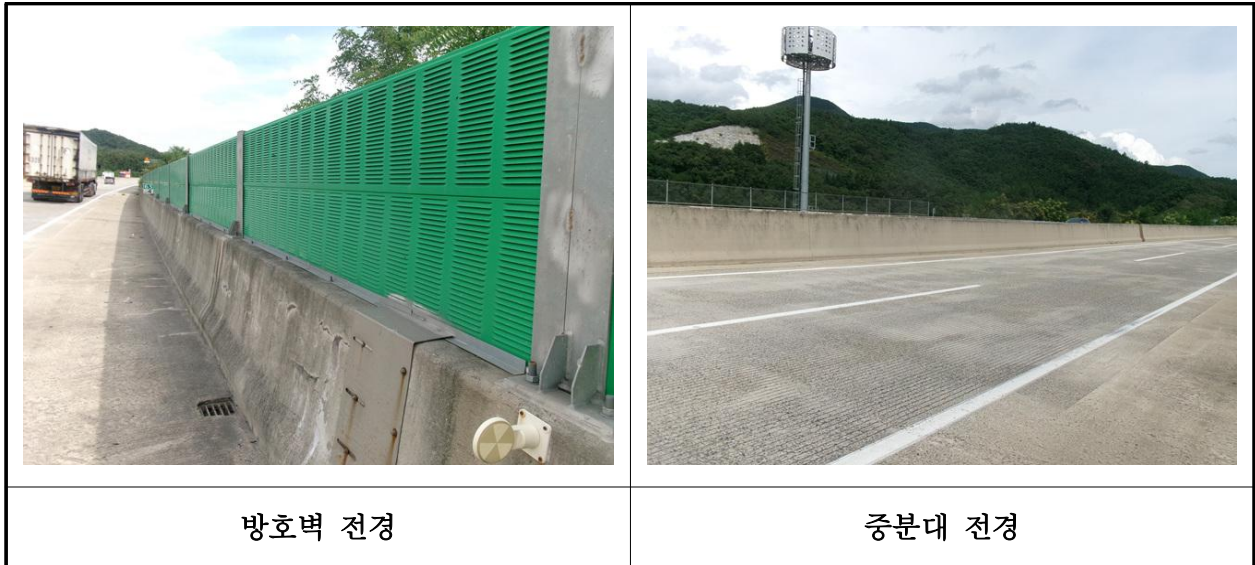
【사진 22.3.46】 방호벽 및 중앙분리대 전경
