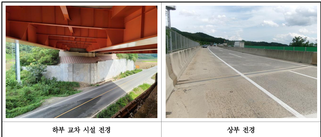
【사진 22.2.1】 부재 현장측정 전경
