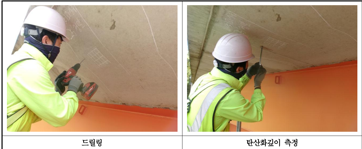
【사진 22.4.3】 탄산화 깊이 측정 현장사진
