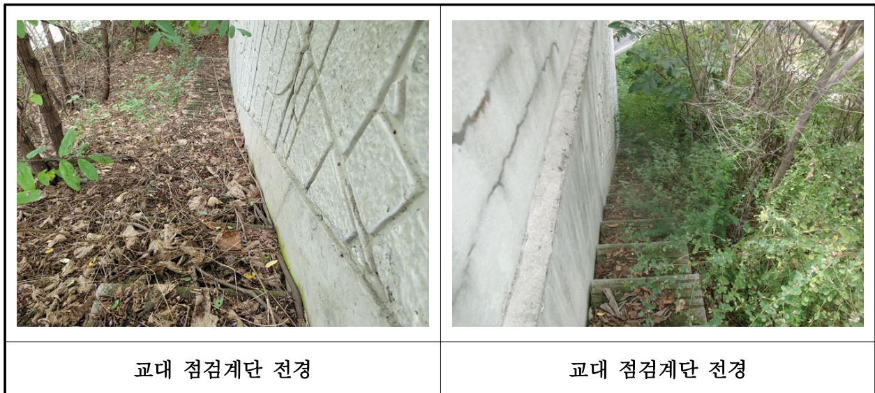
【사진 22.3.24】 교량 점검시설 전경
