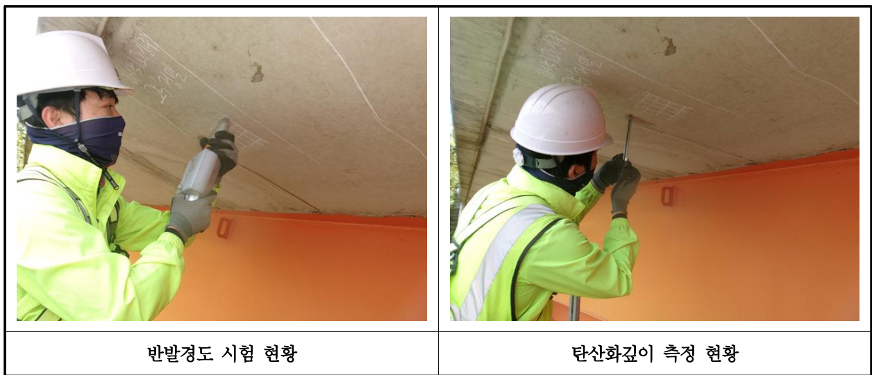
【사진 22.4.1】 콘크리트 내구성조사 현황
