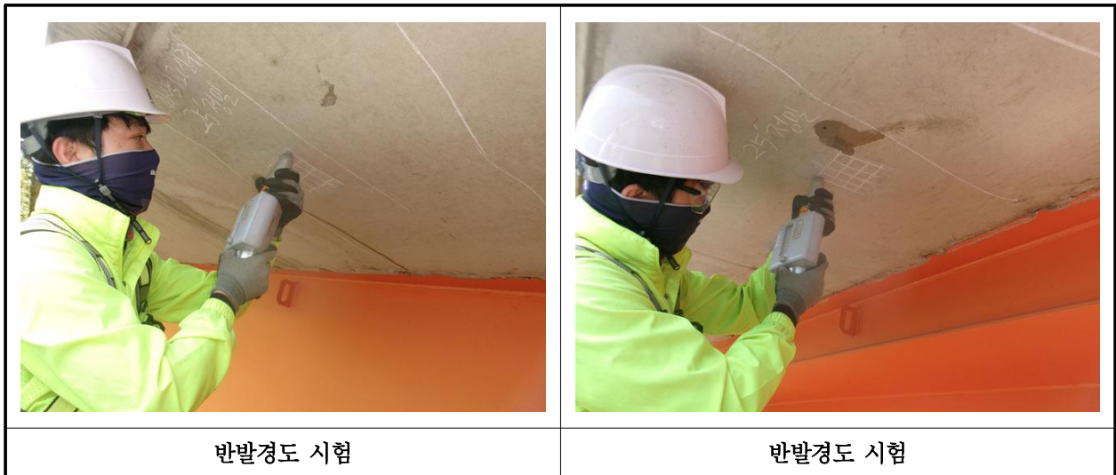
【사진 22.4.2】반발경도시험 현장사진
