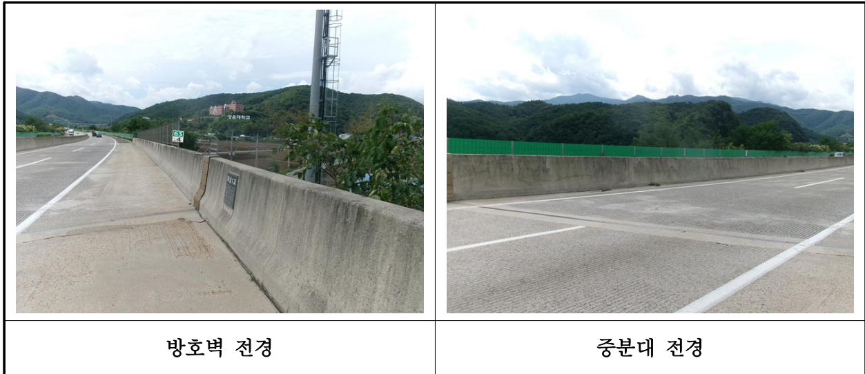
【사진 22.3.22】 방호벽 및 중앙분리대 전경
