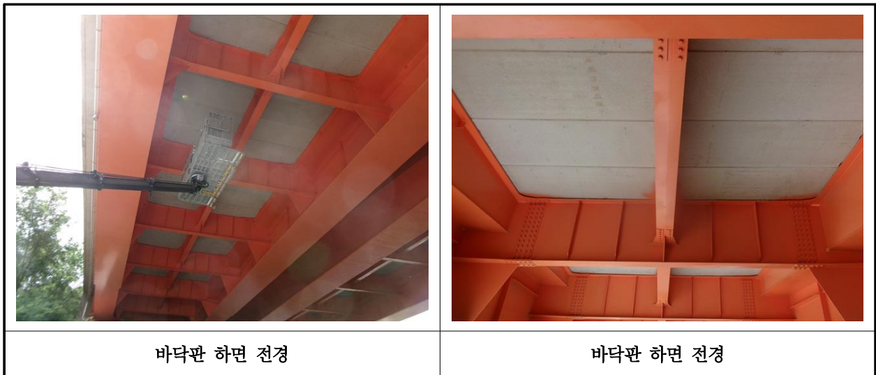
【사진 22.3.27】 바닥판하면 전경
