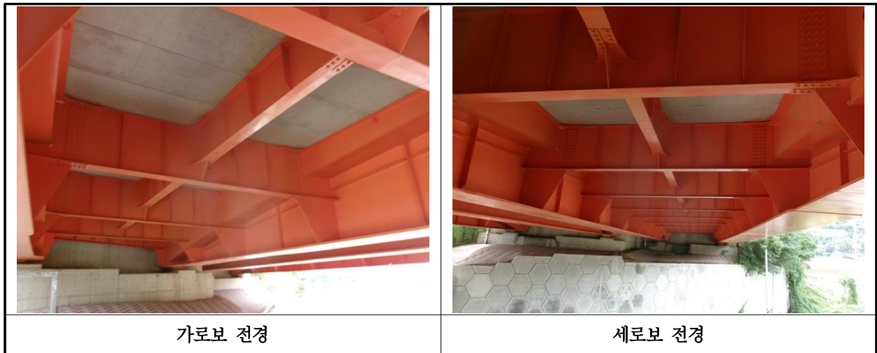
【사진 22.3.6】 가로보 및 세로보 전경
