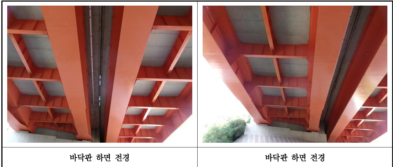
【사진 22.3.2】 바닥판하면 전경
