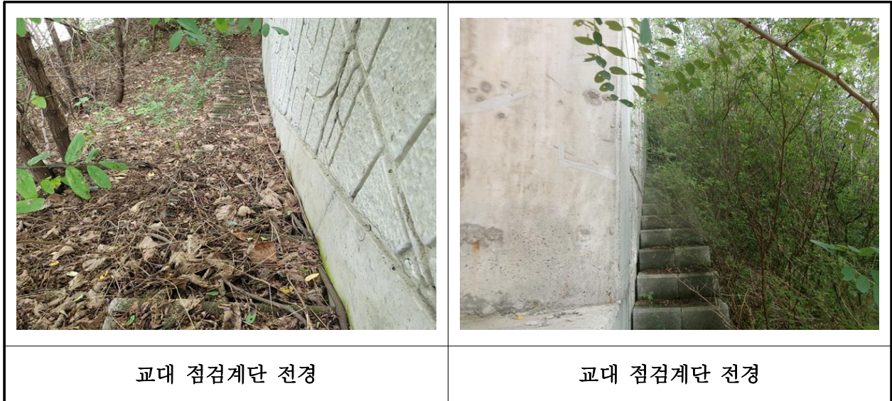
【사진 22.3.48】 교량 점검시설 전경
