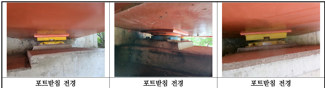
【사진 22.3.11】 교량반침 전경
