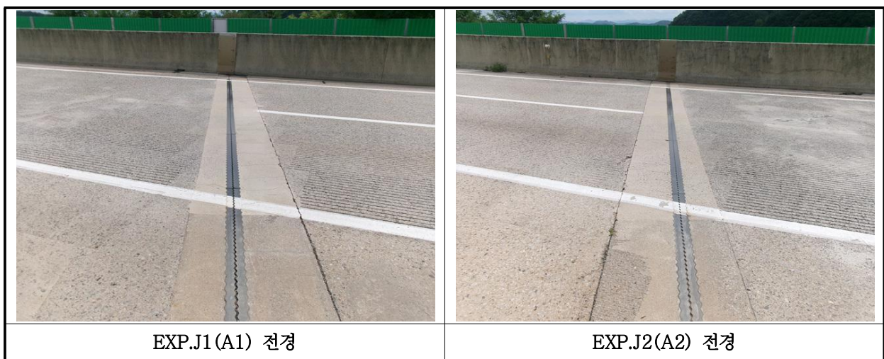
【사진 22.3.15】 신축이음장치 전경
