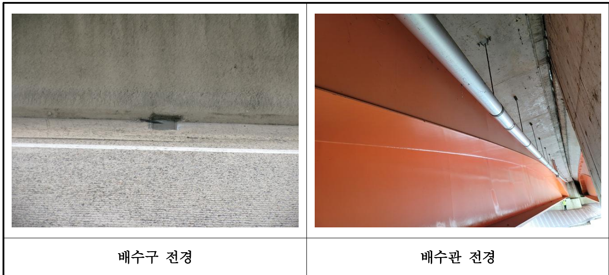
【사진 22.3.20】 배수시설 전경
