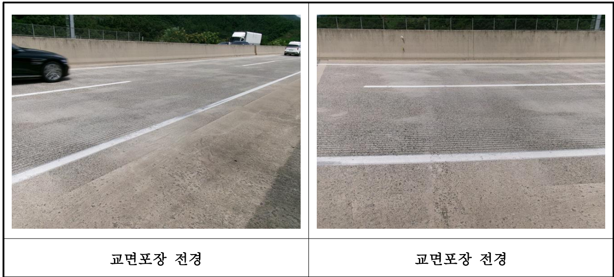
【사진 22.3.42】 교면포장 전경
